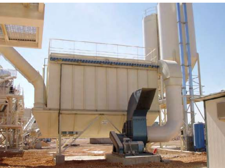
Instalaciones de filtración de 588 m 2 de superficie filtrante.
